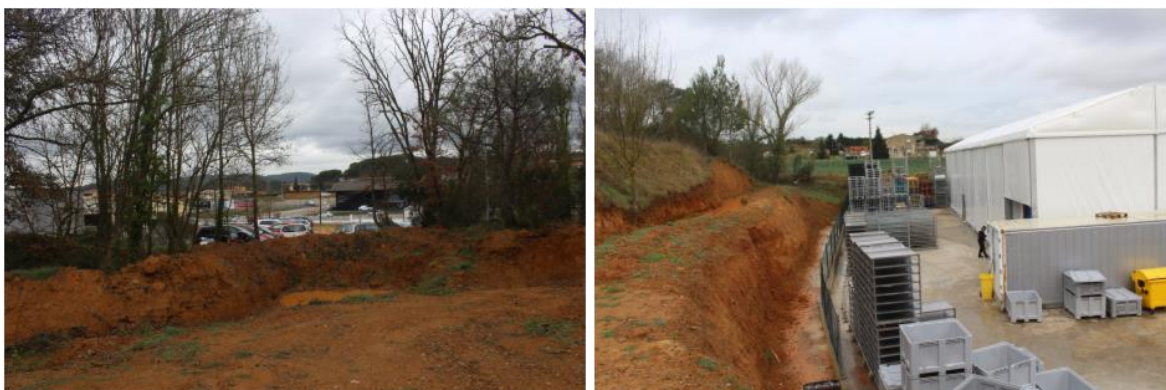
Figura 1: Talussos verticals en l'àmbit d'actuació.
