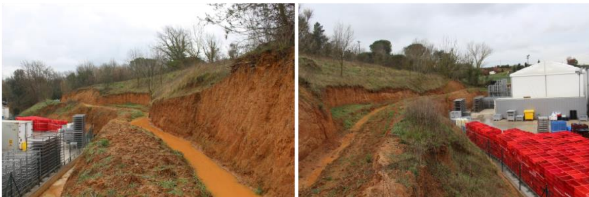
Figura 4: Sistema de drenatge als talussos.
