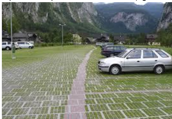
Figura 36: Aparcament amb llambordes de drenatge. Font: MITECO.
